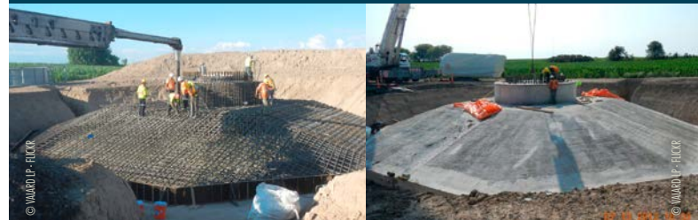
Fondations d'une éolienne de 2 MW
